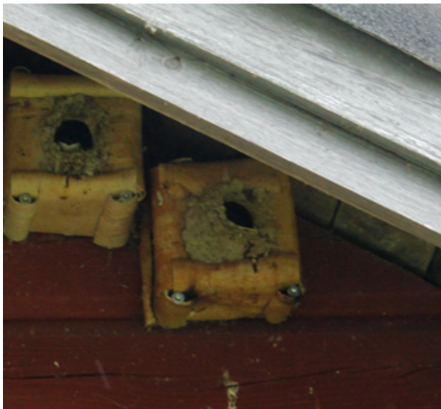
10. Tarkempi kuva kiinnityksestä: Kiinnitys tehdään pitkillä ruuveilla pöntön rakennetta rikkomatta. Kuvasta näkee myös kiinnityssuunnan: reiän alapuolelle etuseinään tulee vaakasuuntainen "kynnys".
